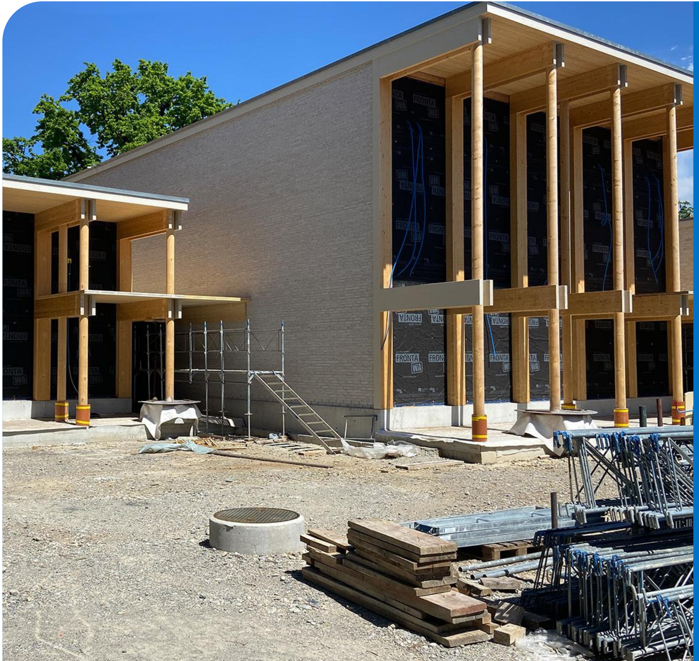
Chantier du Portail du Nations en cours de réalisation, vue sur les pavillons © 2024 FDPN
